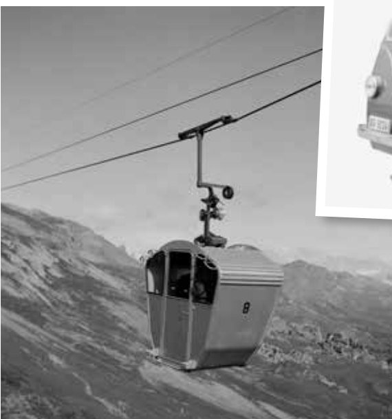
Gondelbahn Cry-d'Er-Bellalui in Lens VS, erbaut 1951.
