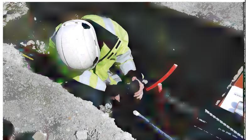
^ **Kabel mit Muffen verbinden** Die Netzelektrikerin verbindet zwei Kabel mittels einer Muffe (Verbindung). Dazu arbeiten die Berufsleute oft in Schächten.
