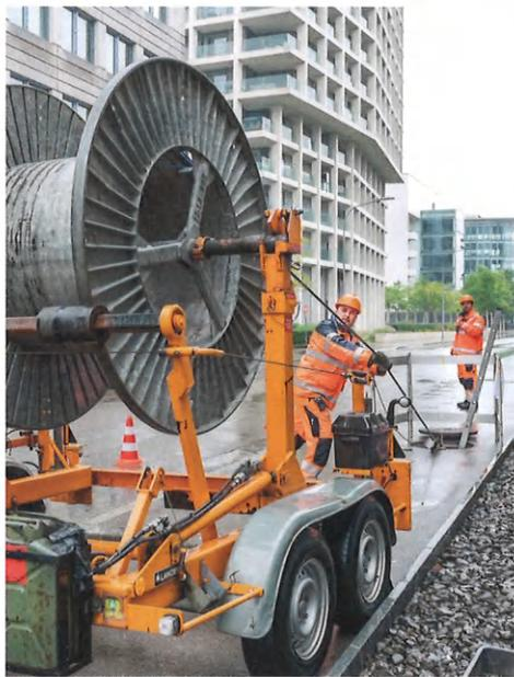
> **Fahrleitungen montieren** Die Berufsleute installieren und warten auch Fahrleitungen für Züge, Trams und Busse. Bei Störungen sind sie sofort einsatzbereit.
